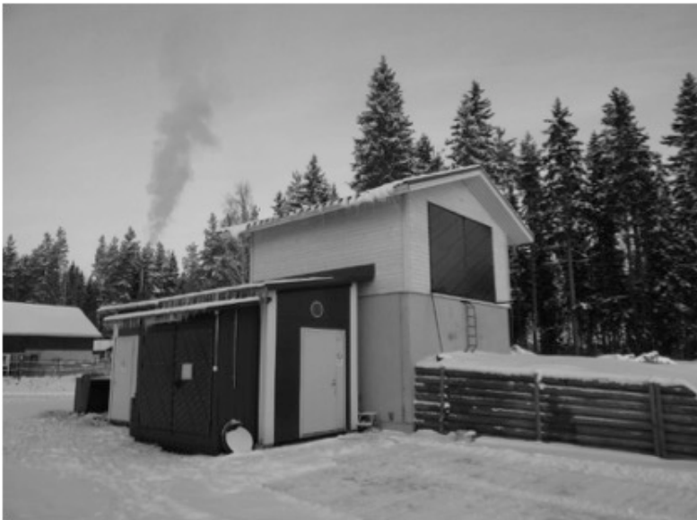
Kuva 1. Kuittilan tilan hakesiilo ja puukaasutuslaitos. Etualalla kaasutuslaitos, johon puu johdetaan taustalla olevasta hakesiilosta tyhjiöputkea pitkin. (Kuva: Jani Lukkarinen, 12/2013)
