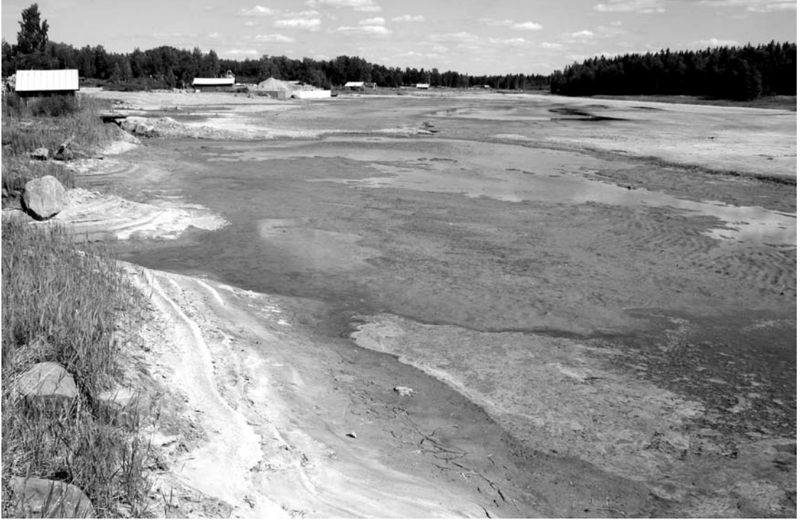
Kuva 2. Sommarösundin lahden sisempi osa kuivatettuna kesäkuussa 2007. Etualalla valmiiksi kaivettua rantapenger-tä. (Kuva: Harri Tolvanen)
