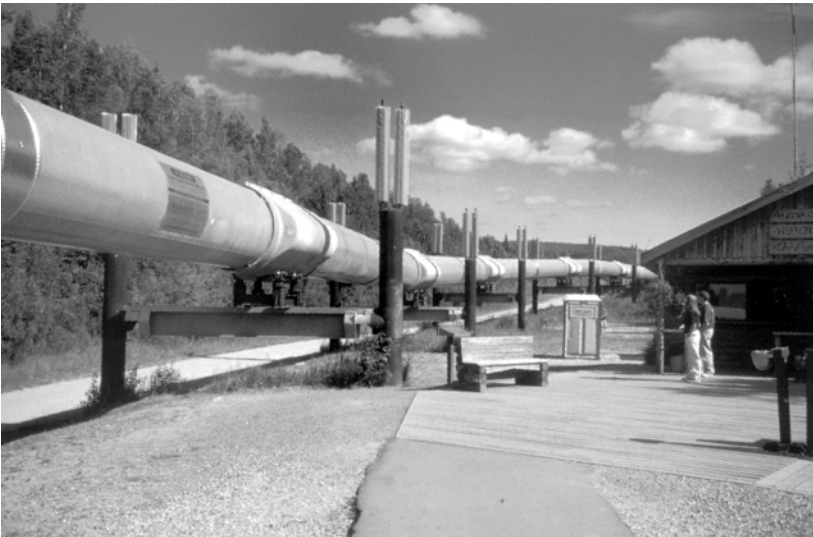
Kuva 6. Tämän Brudhoe Bayltä Valdeziin johtavan noin 1 300 kilometriä pitkän öljyjohtoon rakentaminen tuli kalliiksi. Näin paljolta siksi, että johto kulkee pitkiä matkoja jäärikkaalla ikiroudalla, joka on pystytävä pitämään roudassa. (Kuva kirjoittajan, 07/1999)
